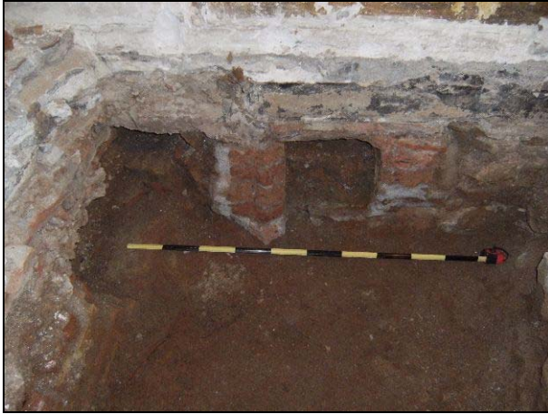
FOTO 9. Vista parcial de la cala 4 on podem apreciar la claveguera (ja escapçada) UE 123 que farceix el retall UE 124. A l'esquerra podem apreciar, en el tall, la possible claveguera UE 126 que farceix també el seu retall de construcció (en aquest cas UE 127)
