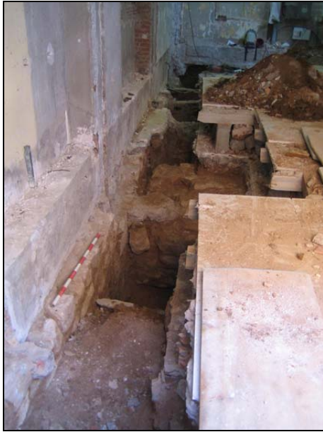
FOTO 25. Vista general de la cala realitzada a la banda nord de la finca.
