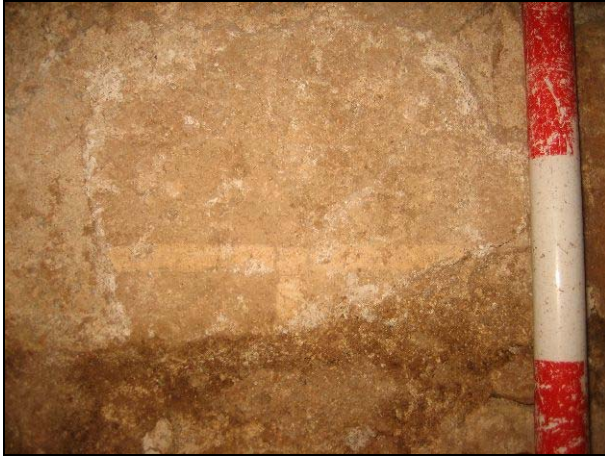
FOTO 17. Detall d'un carreu del fonament de la façana de l'edifici actual que conserva un arrebossat amb un encintat. Això demostra el reaprofitament d'aquest carreu d'una construcció anterior
