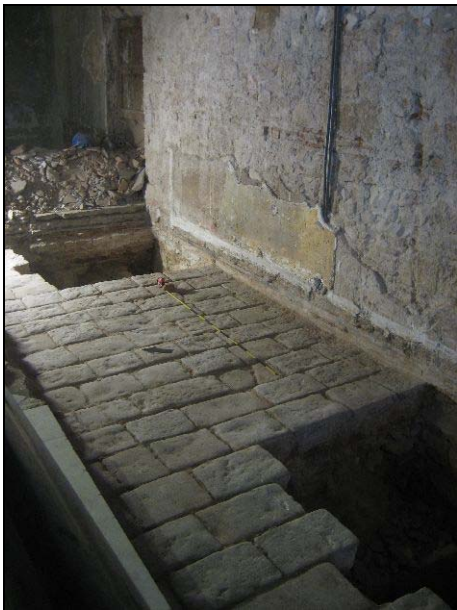
FOTO 3. Vista general del paviment de llambordes UE 104 entre les cales 2 i 3
