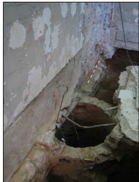
FOTO 32. Vista general del pou UE 30 i la banquetta de fonamentació UE 07 del mur a enderrocar.
